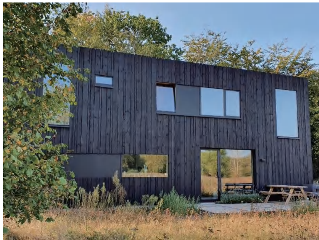
用Presta BioFinish和亚麻籽油处理过的房子。
