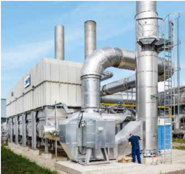
现代化的Ecopure RTO五塔系统在其新的运作地点---Ball饮料包装公司在德国盖尔森基兴的工厂。
