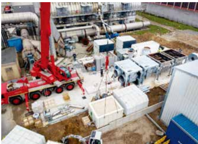
结合现有系统和新组件的Ecopure® RTO装置。
