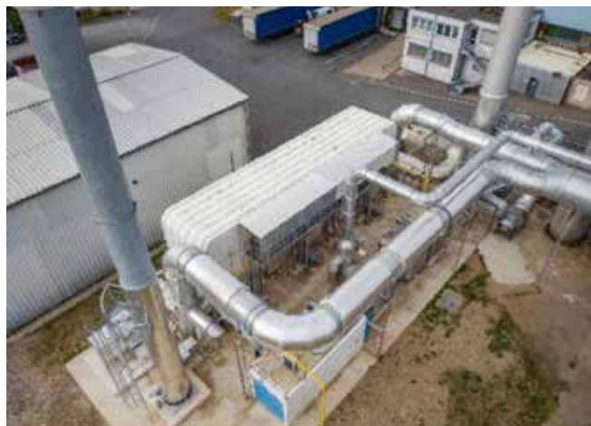
德国盖尔森基兴Ball饮料包装公司现代化的Ecopure RTO五塔系统
